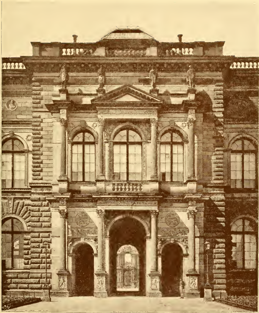
Gottfried Semper: Nordeingang der Dresdner Galerie
